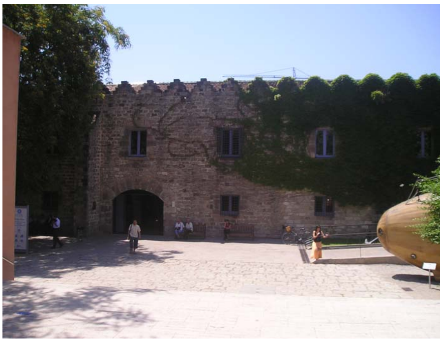
Pati actual del Museu Marítim, on va tenir lloc l'excavació.
